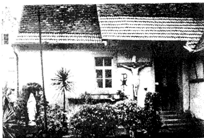
Eingang zum Kindergarten (Nord-Hofseite) vor der Renovierung.
