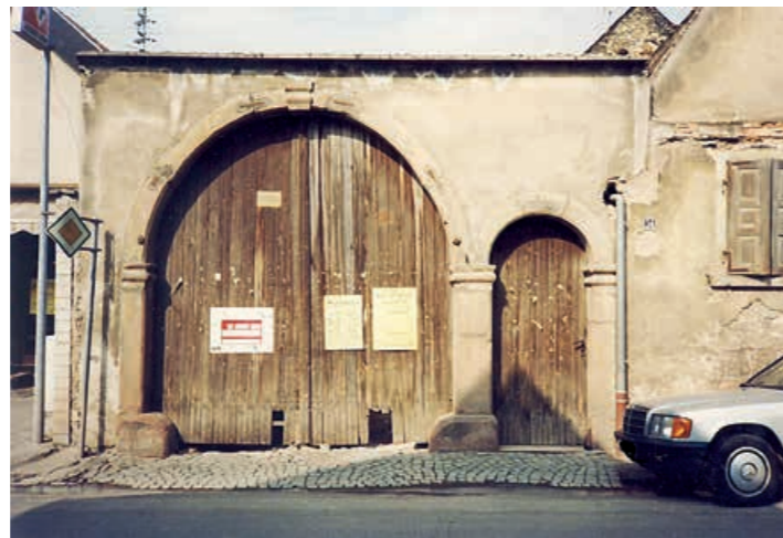
Hauptstraße Nr. 14 vor dem Abriss
